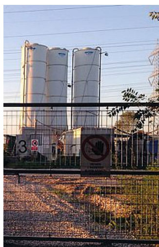
Il cantiere nell'area Malcontenta C
